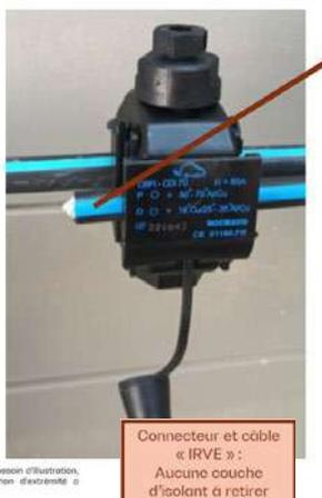
La dérivation Individuelle est raccordée coté client sur des Connecteurs Porte Fusibles ( Ces matériels sont conçus pour **perforer une seule couche** d'isolant Il est donc nécessaire de **retirer une couche d'isolant** d'un câble « IRVE » lors de la confection de la dérivation individuelle pour IRVE coté raccordement sur CPF.
